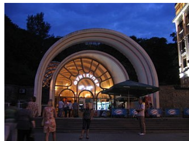
基辅缆车下站
